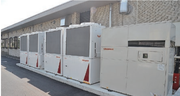
建物前に設置されたガスコージェネレーションシステムなど
